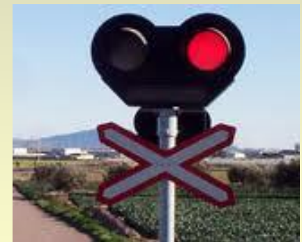
Pas a nivell amb barreres
