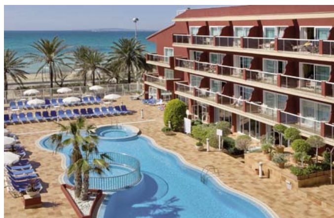
A les Illes la majoria dels edificis estan estretament lligats al sector turístic. Font: Hotel Neptuno.
