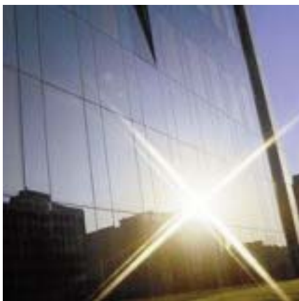
Fasana d'un edifici amb plaques solars per l'aprofitament enegètic al seu interior.
