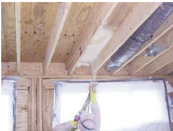
Aïllament tèrmic en un habitatge.
