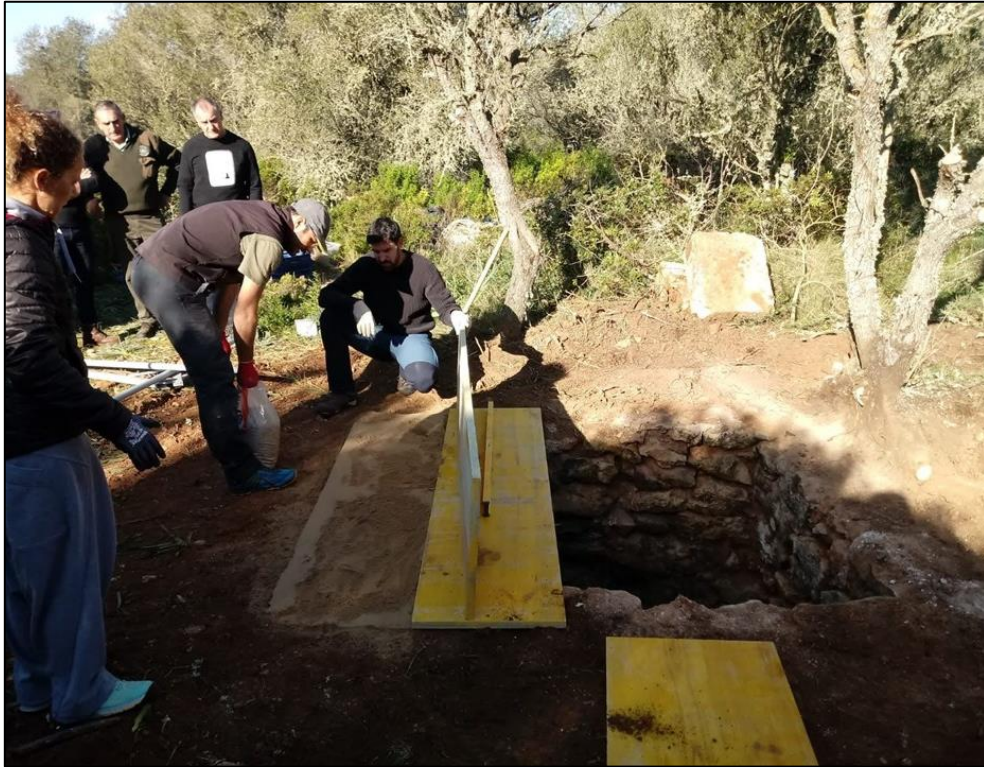
Brocal desmontado y montaje de plataforma de trabajo y seguridad en la boca del pozo.
