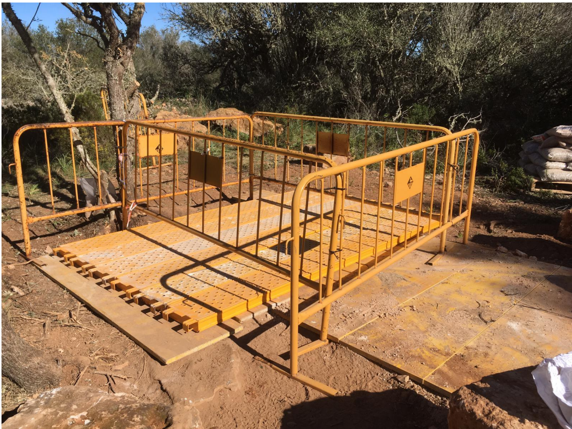
Área de trabajo cerrada una vez terminados las tareas de exhumación.
