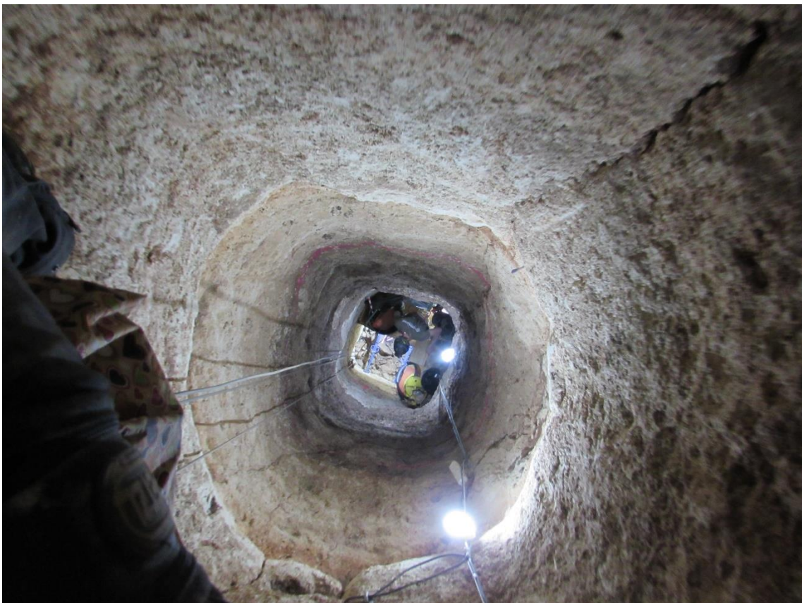
Vista de la plataforma de seguridad y el fondo del pozo.
