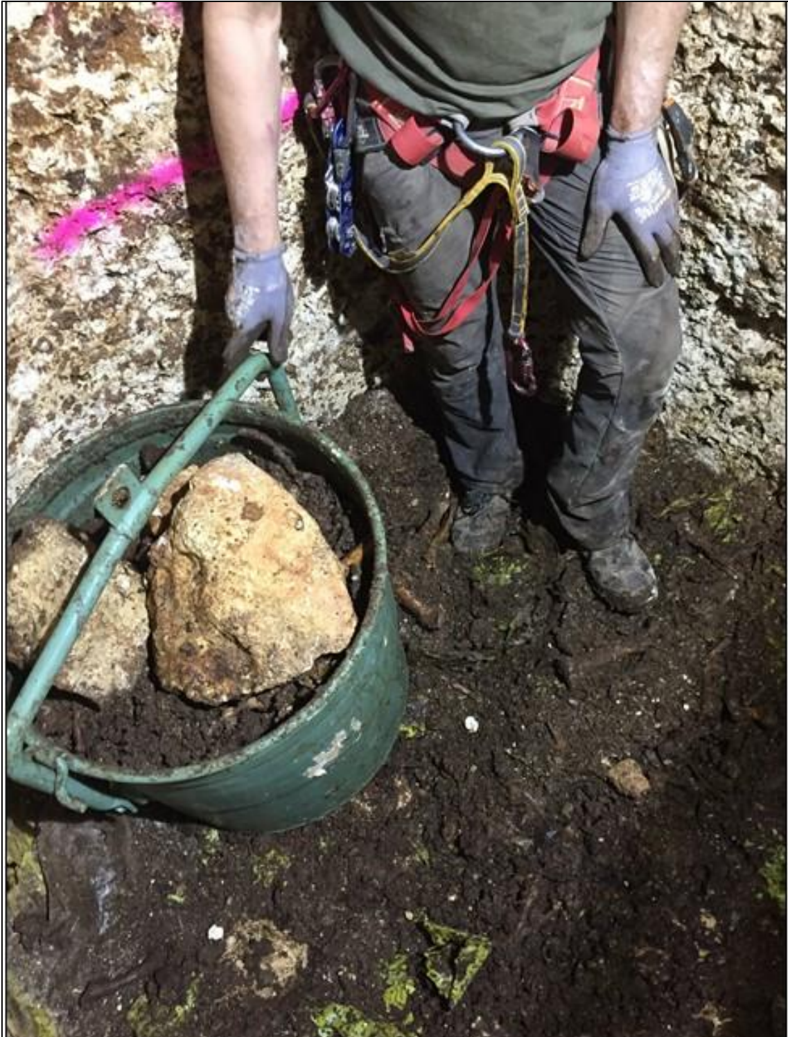
Vaciado de piedra y tierra del interior del pozo.
