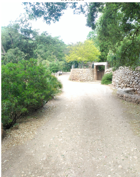
Fotografia 2. La secció del camí és d'entre 4 i 5 metres i el ferm de terra compactada.
